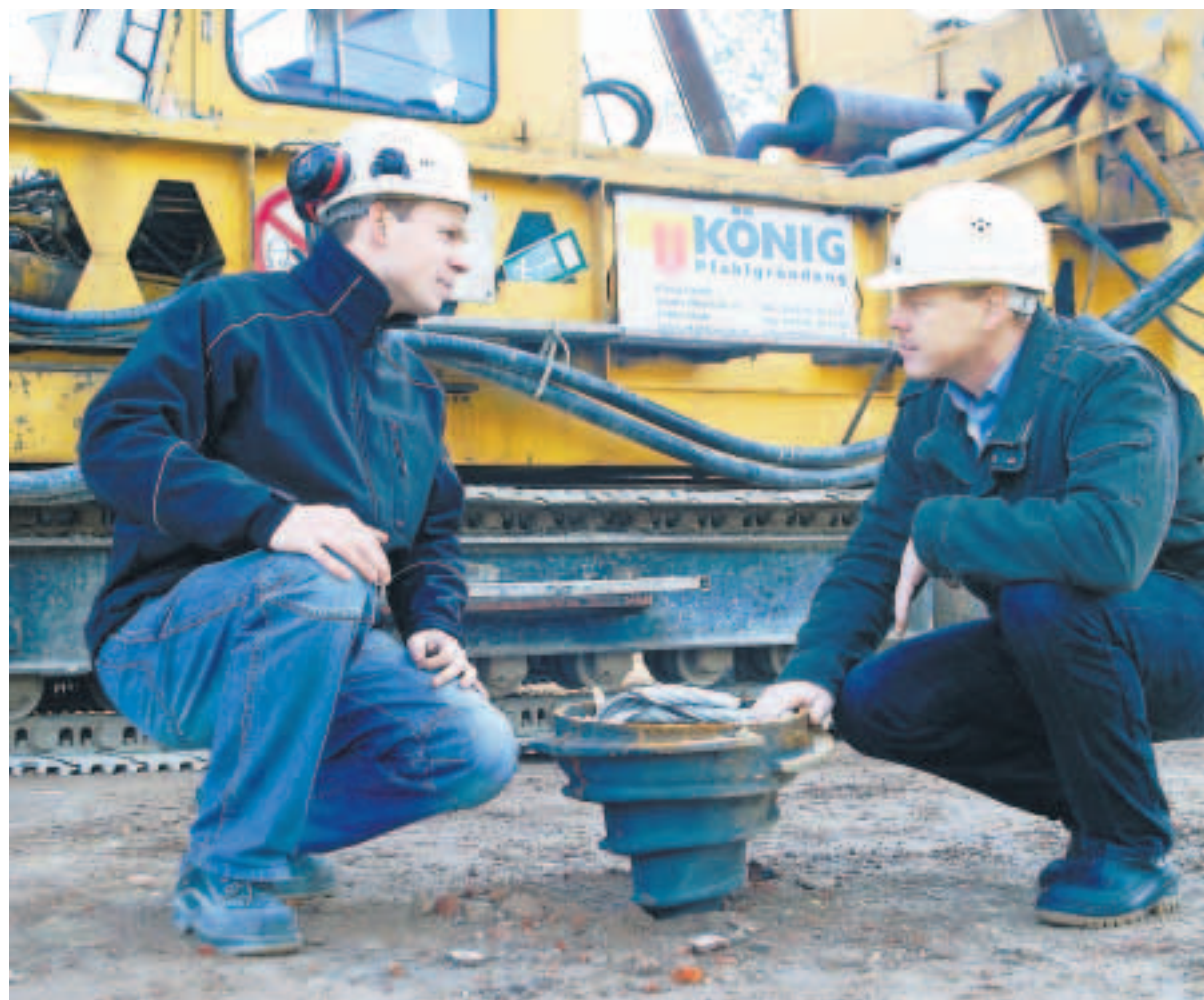
Ideensuche: Maschinen und Bohrspitzen die zur Pfahlgründung genutzt werden, sollen moderner werden. Qualitätsmanager Christian Müller von der Firma König erläutert Ingenieur Jörg Schrickel vom Transferzentrum die Arbeitsweise.
